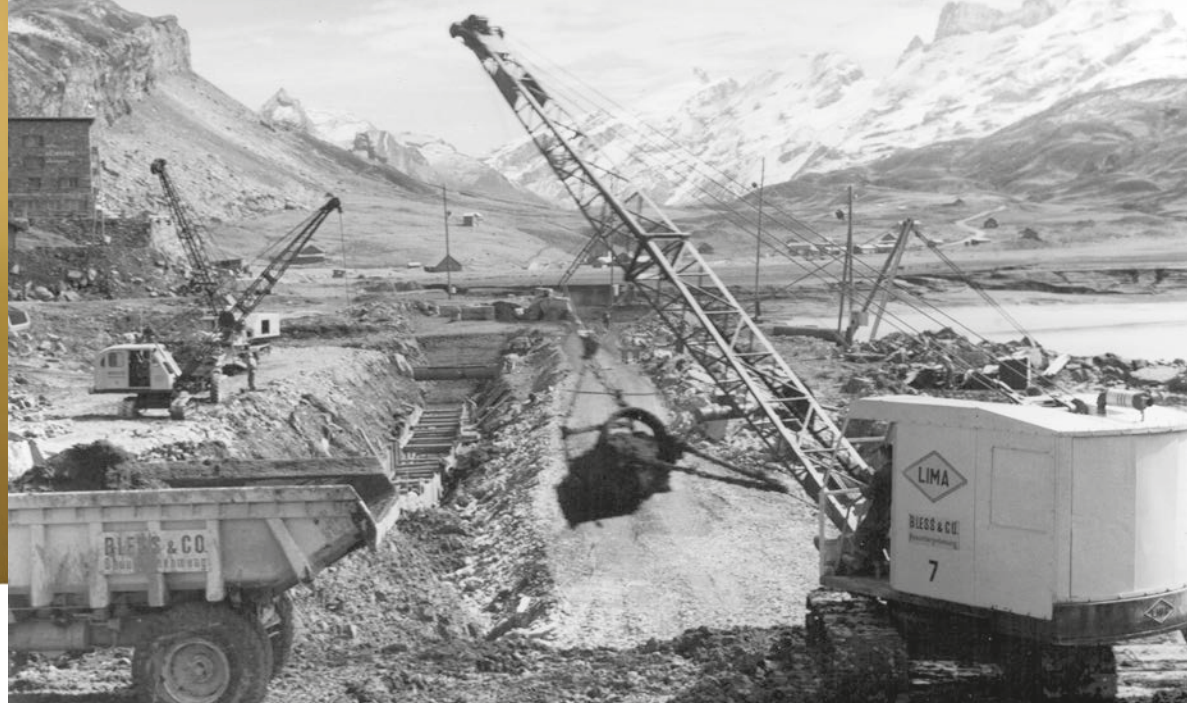
Melchsee-Damm, Dichtungs-Diaphragma, August 1956
