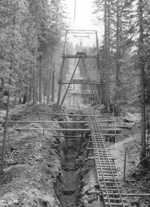
Bau Druckleitung unterhalb Umladestation Jäst, August 1956
