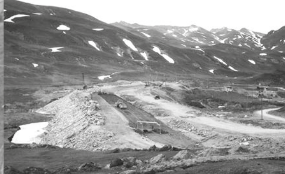
Bau Tannenseedamm, Sommer 1958
